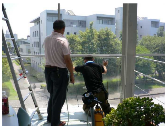
窓フィルム貼付施工状況
