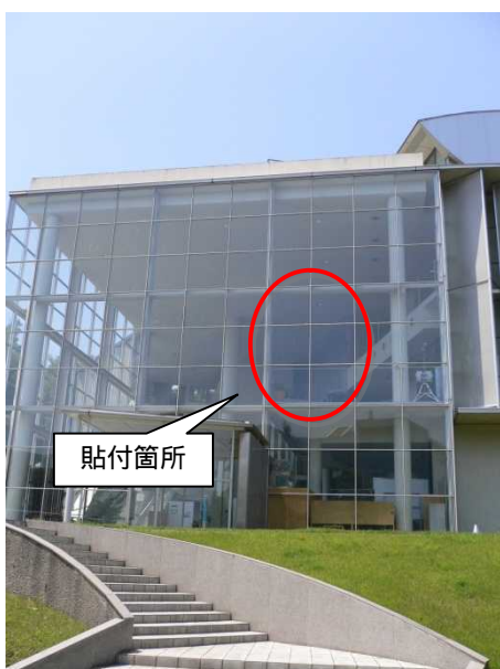
館 窓フィルム貼付場所
